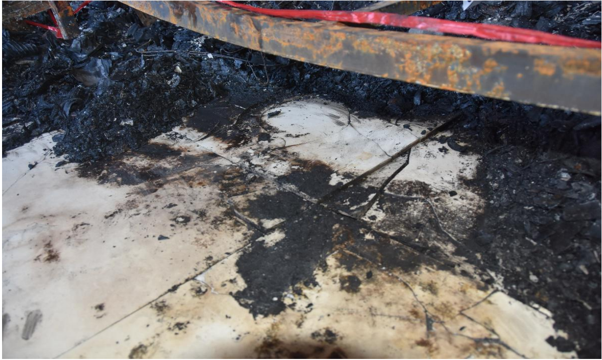
图片 8：瓷砖炸裂位置周边的炭化堆已黏附在瓷砖上（由东北向西南拍摄）
