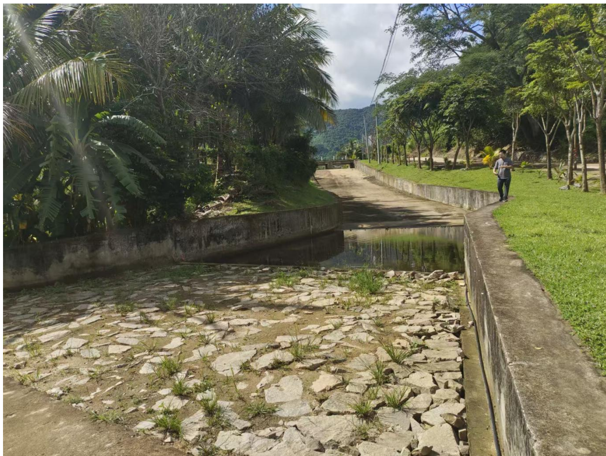
图 2-13 三败老水库现状溢洪道
