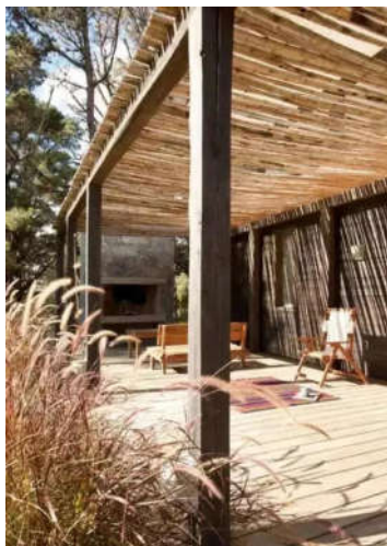
竹木板遮阳连廊
